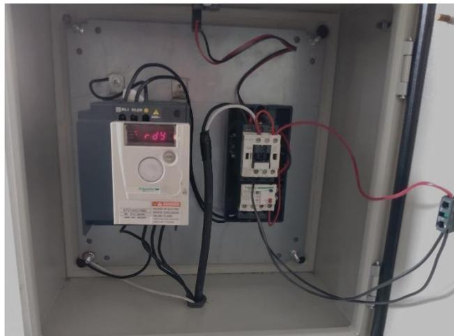
**Figura 34.** Conexión a 220V del variador de frecuencia.
